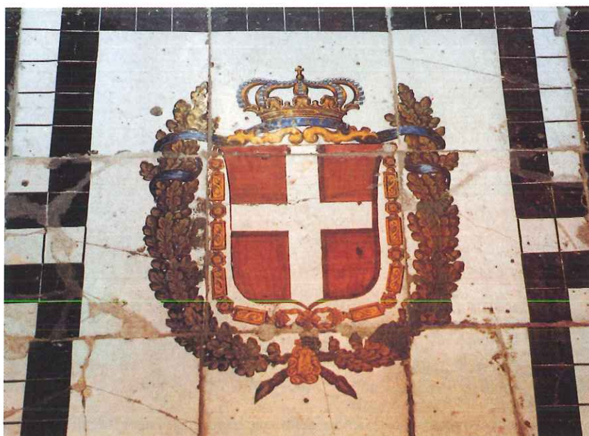
Figg. 15-16 La fase di catalogazione, pulizia ed incollaggio delle piastrelle del pavimento ottocentesco del Museo mineralogico; particolare del pavimento con lo stemma sabaudo.
